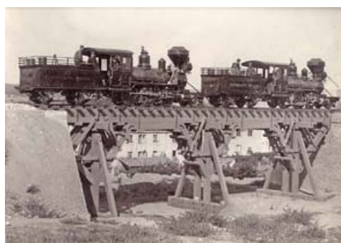
Pruebas de carga realizadas por el Batallón de Ferrocarriles. 1905.
