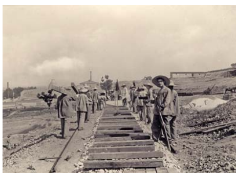
Batallón de Ferrocarriles renovando vía. 1905
