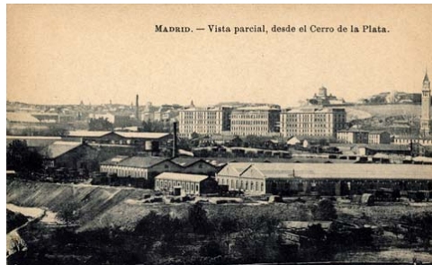
Vista de las oficinas de la Compañía MZA desde el Cerro de la Plata. Hacia 1905.
