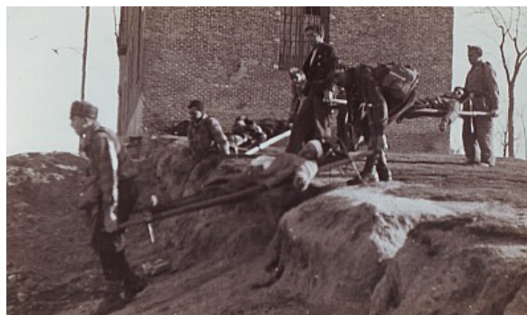
Sanitarios en el frente de Madrid 10
